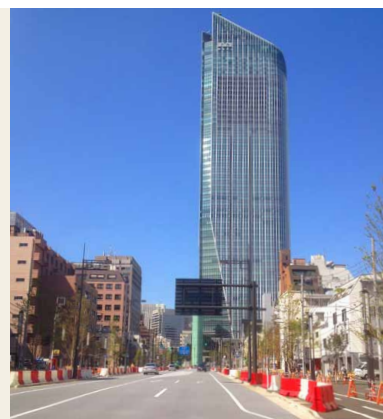
Il complesso "Toranomon Hills" e il raccordo anulare n. 2
