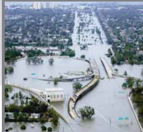
Valone di Mezzanotte - Lato monte /Uphill side
