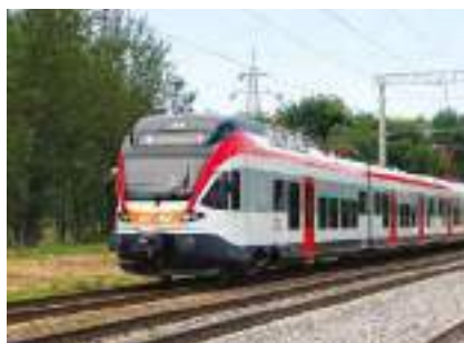
Ferroviario - Segnalamento Railway - Signalling
