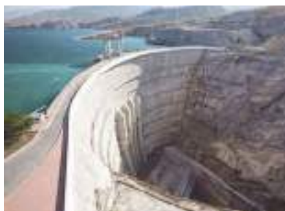
Impianti energetici Energy plants
