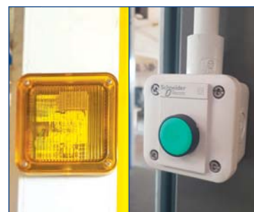
Quadro di comando con display esterno - Lampeggiante IP65 - Pulsante di apertura / Control panel with external display - Flashing indicator light IP65 - Opening button
