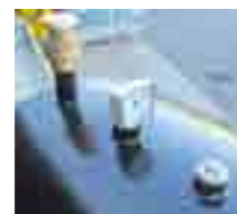
Indicatore di livello visivo e filtro ai carboni attivi. Mechanical level gauge and activated carbons vent filter.
