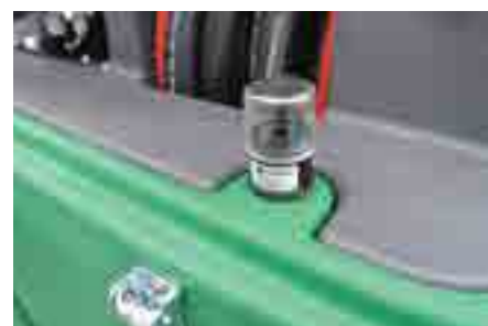
Détecteur de fuites dans l'espace interstitiel. Interraum-Überwachungssystem.
