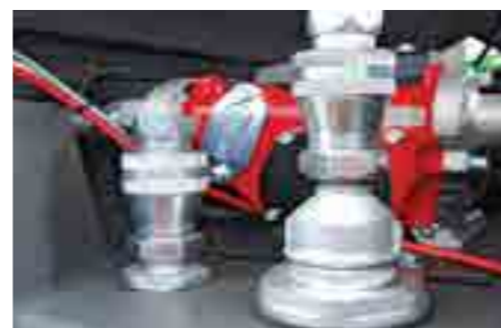
N.2 быстроразъемных соединения 1/2" для подключения к генераторной установке (прямая + обратная топливная магистраль + всасывающая труба). n. 2 rapid couplings, size 1/2", for generator sets connection (feeding + return line+ suction pipe).
