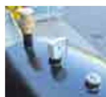
Механический уровень и фильтр на основе активированного угля. Mechanical level gauge and activated carbons vent filter.
