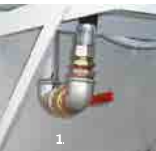
1. Всасывающая линия suction pipe from the top of the tank.
