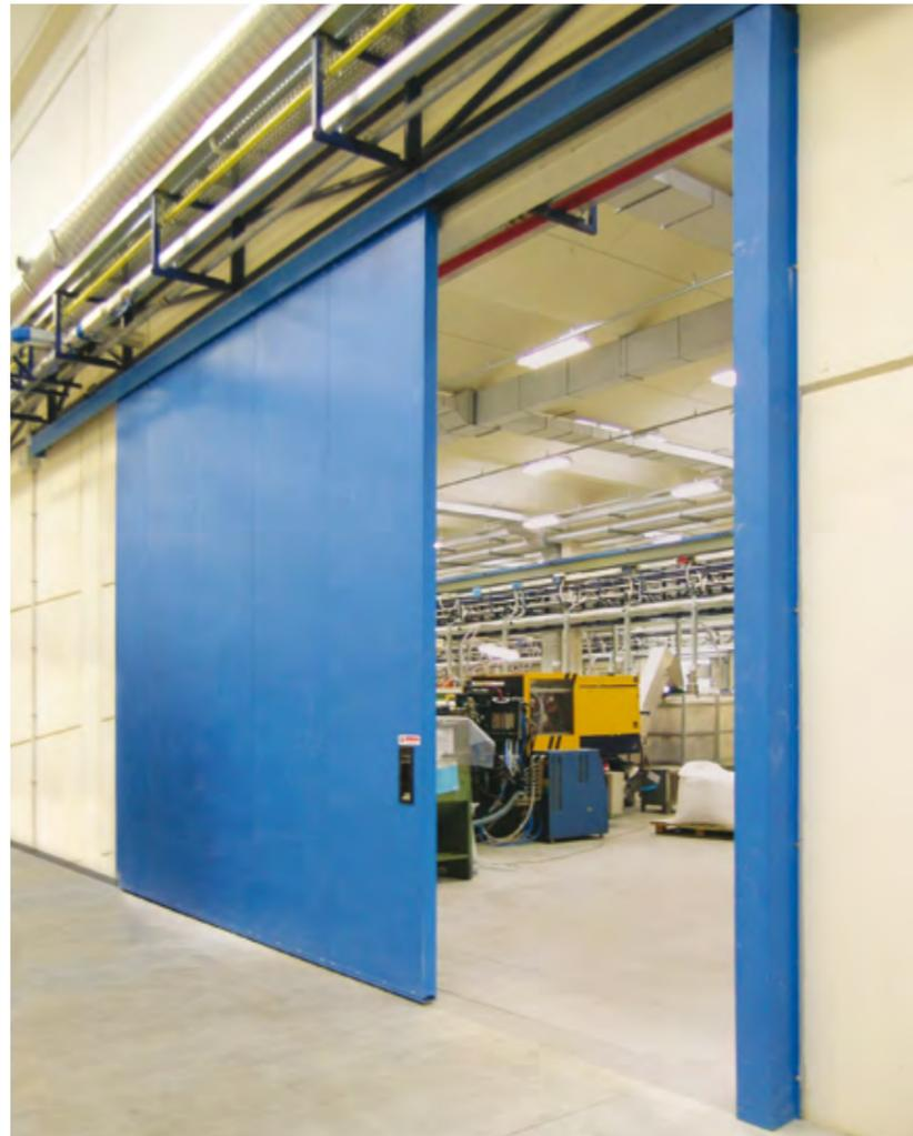
Robusto e sicuro, il portone scorrevole tagliafuoco rappresenta una nuova concezione di chiusura antincendio. Realizzato a una o due ante contrapposte o sovrapposte, il portone tagliafuoco garantisce la massima sicurezza attiva e passiva delle persone, delle strutture e dei beni.
