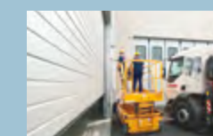
Montaggio e installazione Assembling and installation
