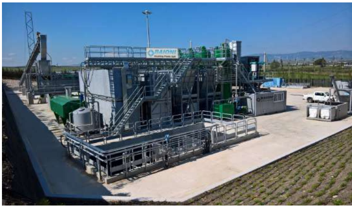
Impianti mobili di bonifica fanghi e terreni contaminati Mobile soil remediation plants Installations mobiles pour le traitement de boues et des sols contaminés Plantas móviles para el tratamiento de suelos y lodos contaminados
