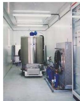
Interno del container ISO con sala macchina installata sopra ad un deposito ghiaccio
