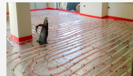
Impianto Radiante a Pavimento Ristrutturazione 130 mq
