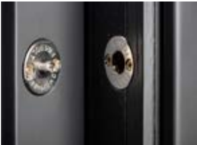
Rostro regolabile Adjustable door hinge bolts
