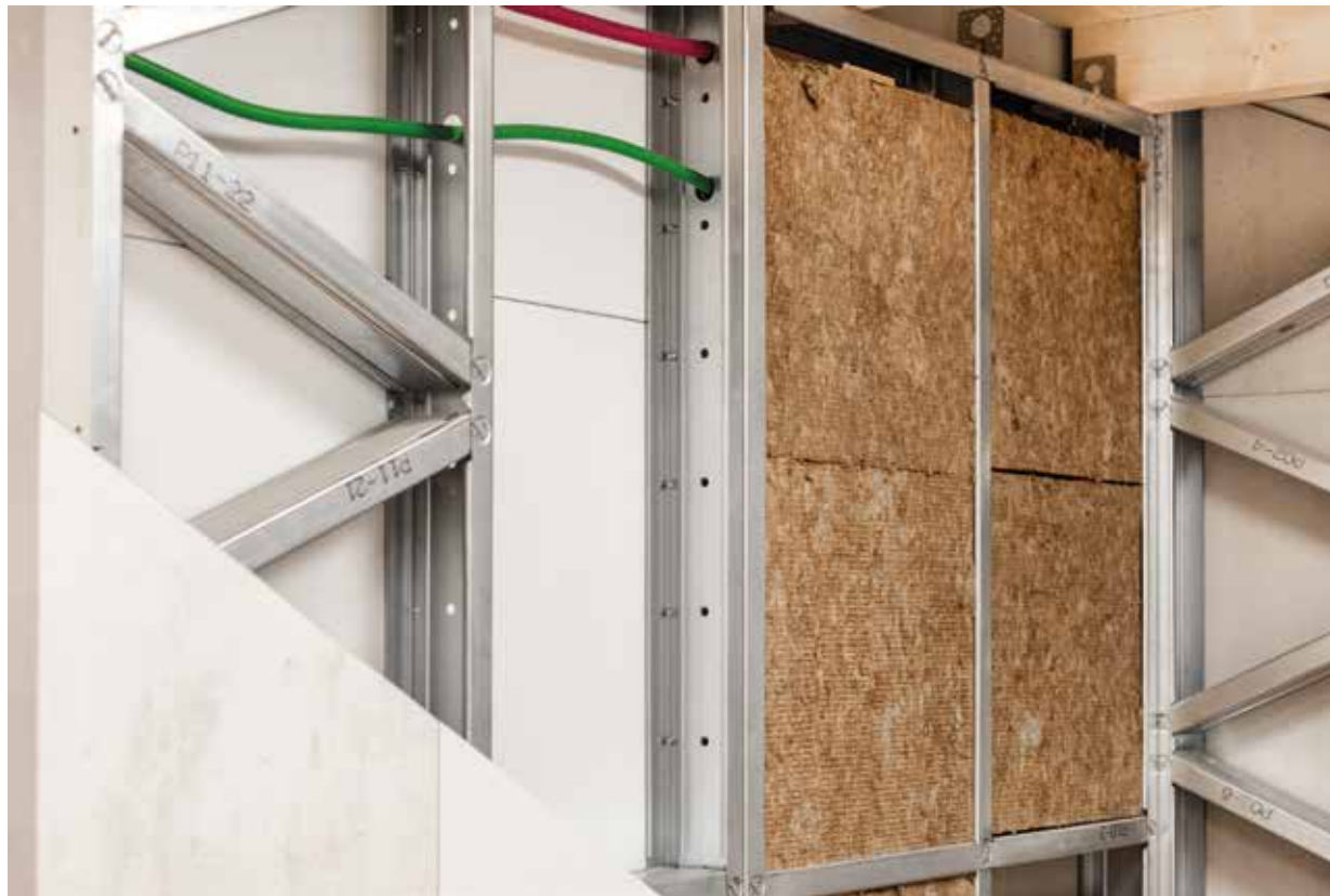
SCHEMA DI PARETE INTERNA SEMI-FINITA
