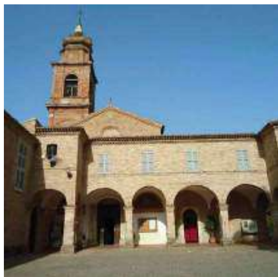
CAMPANILE DELLA CHIESA DEL CONVENTO DEL BEATO SANTE MOMBAROCCIO (PU)
