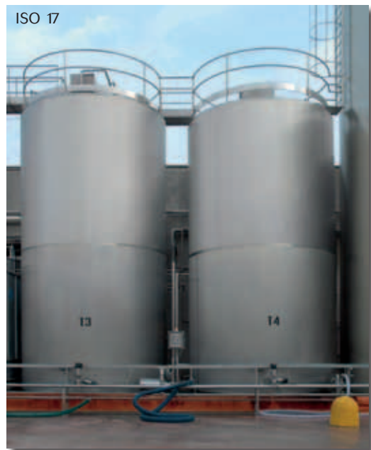
Tank di stoccaggio latte da lt 80.000 isolati con poliuretano e manto saldato
