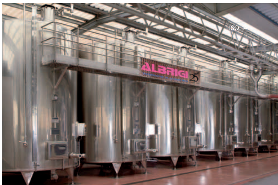
Batteria di serbatoi refrigerati da lt 30.000 totalmente isolati con manto saldato
