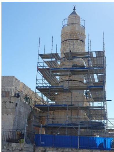
Torre di Davide durante le fasi di restauro, utilizzo di griglia di basalto nei supporti orizzontali; La parte restaurata della cupola della torre viene ripristinata in tondini di Basalto
