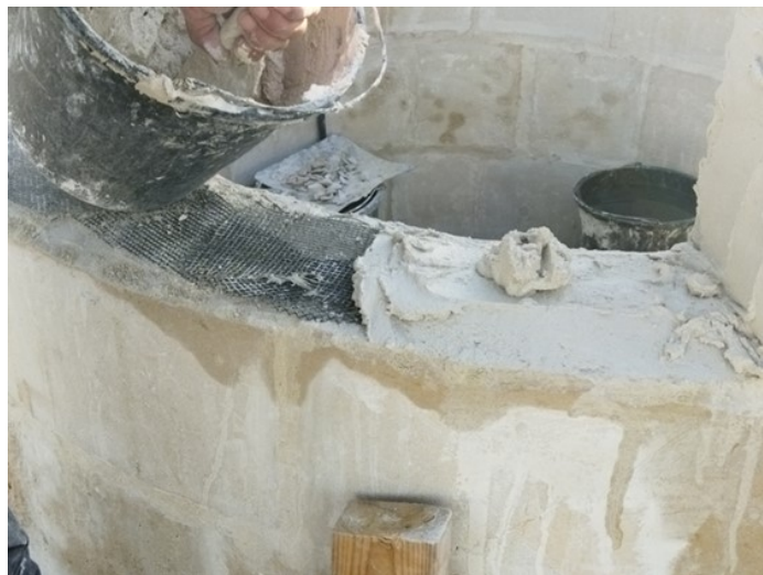
Torre di Davide durante le fasi di restauro, utilizzo di griglia di basalto nei supporti orizzontali; La parte restaurata della cupola della torre viene ripristinata in tondini di Basalto
