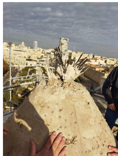
Torre di Davide durante le fasi di restauro, utilizzo di griglia di basalto nei supporti orizzontali; La parte restaurata della cupola della torre viene ripristinata in tondini di Basalto
