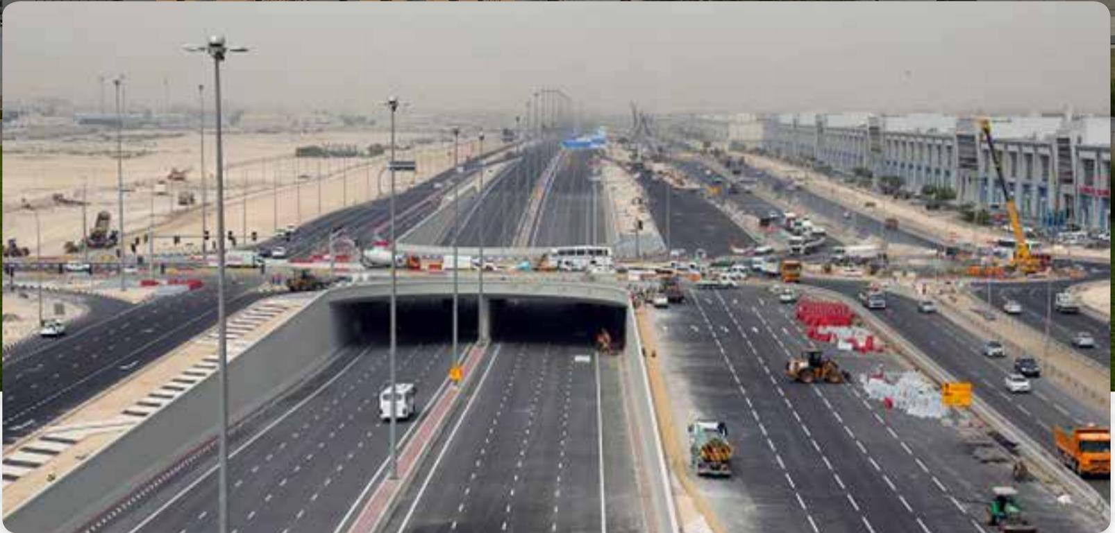
Rawdat Al Khail Street Extension include la costruzione di 30 km di piste ciclabili e pedonali, cinque principali scambi multilivello e la costruzione di un tunnel unidirezionale con una lunghezza di 650 metri per facilitare l'accesso a Barwa City.
