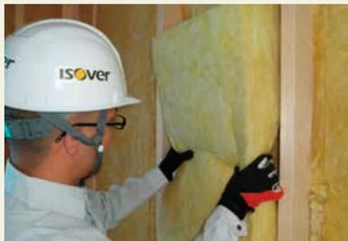
Materiali per l'isolamento termico a base di fibre minerali utilizzati in varie forme.
