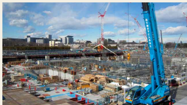
Il "Musashino-no-mori Sport Center" in costruzione
