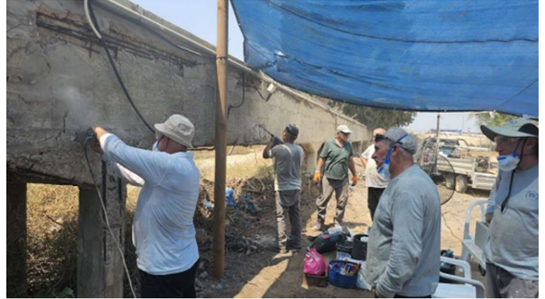
Formazione sulla conservazione e il restauro del calcestruzzo e sulla conservazione pratica dell'acquedotto del kibbutz (vicino al Kibbutz Masada) costruito negli anni Trenta.
